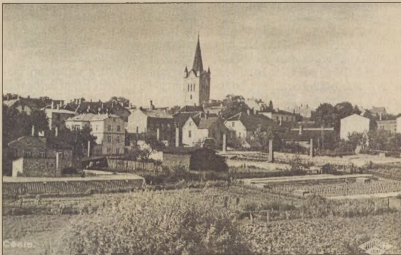
■ Tāds bija skats uz Cēsīm trīsdesmitajos gados. Attēlā skaidri redzamā trīsstāvu ēka ir grāmatizdevēja Kārļa Dūņa nams Rīgas ielā nr. 37. Skats uz ēku no Valņu ielas puses.
